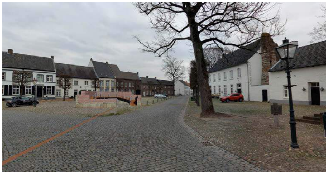
een bouwkundige oplossing; de ruine herleeft.
